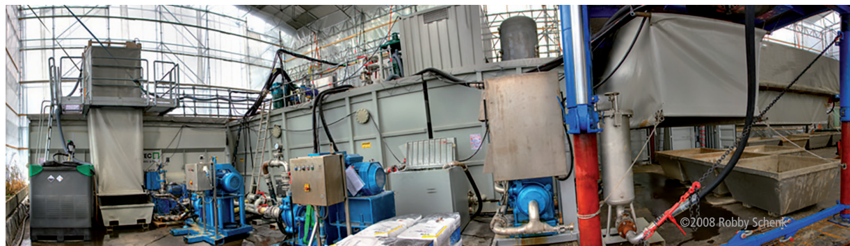
Innenansicht der Behandlungsanlage
